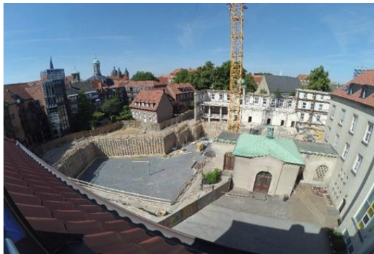
Blick auf die aktuelle Baustelle der Clemensbögen in Münster. Halblinks im Hintergrund ist das Runddach der barocken Clemenskirche (mit grüner Kuppel) erkennbar, rechts vom Krangerüst das Dach der Servatii-Kirche.
