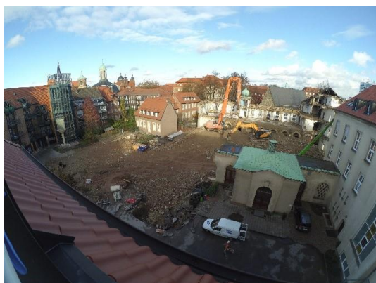
Blick auf die Baustelle der Clemensbögen an der Klosterstraße in Münsters Altstadt
