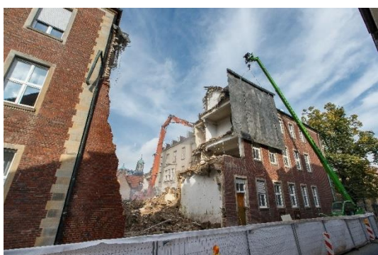
Schutzmatten mussten beim Rückbau des Gebäudeteils zur Klosterstraße eingesetzt werden
