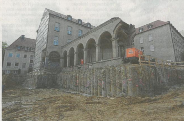
Die Baugrube ist fast komplett ausgehoben. Der alte Kreuzgang soll im Rahmen der weiteren Arbeiten wieder komplett rekonstruiert werden – mit den Originalsteinen. Sie lagern zurzeit in den Baumbergen. Foto: Matthias Ahlke
