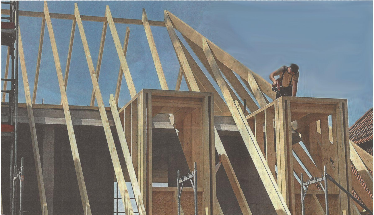
Dachdecker errichten einen Dachstuhl auf einem Mehrfamilienhaus an der Hamburger Straße.
