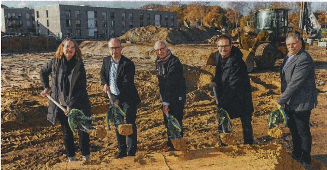
Oberbürgermeister Markus Lewe (M.) und CM-Geschäftsführer Michael Lüke (2.v.l.) setzten den ersten Spatenstich für das CM-Projekt. Mit dabei waren (v.l.) Konvoy-Prokuristin Christa Ransmann, Architekt Andreas Noack und Frank Röbbelen vom Bauunternehmen Schmeing.
