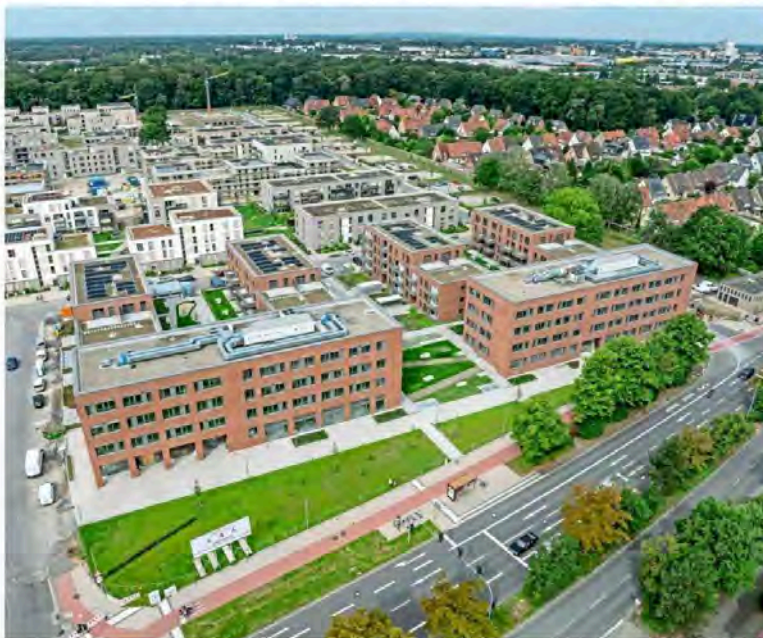
Die von CM errichteten Immobilien im York-Quartier in Münster-Gremmendorf (im Vordergrund), links vorn das Gesundheitshaus an der Ecke Albersloher Weg / Essexweg.
