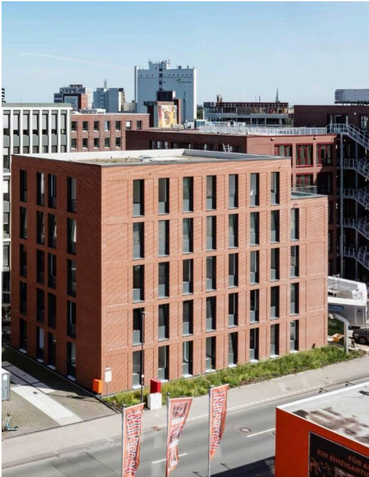
Dieses Bürogebäude im rob17-Ensemble an der Robert-Bosch-Straße in Münster ist von der CM Immobilien Entwicklung veräußert worden.
